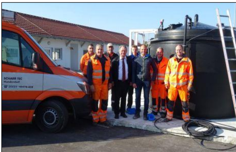
Bei der neuen Anlage zur Phosphatfällung in der Kläranlage
