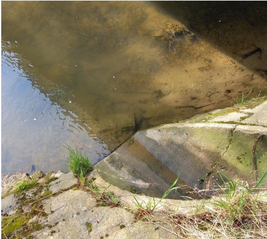
Abbildung 1: Einleitungsstelle A I in die Aiterach mit dem Betonrohr DN 1000 (Stand Mai 2022)
