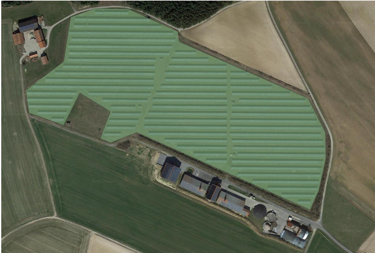
Abbildung 65: Solarparkfläche Schweineck, Bestand Freiflächenphotovoltaik
