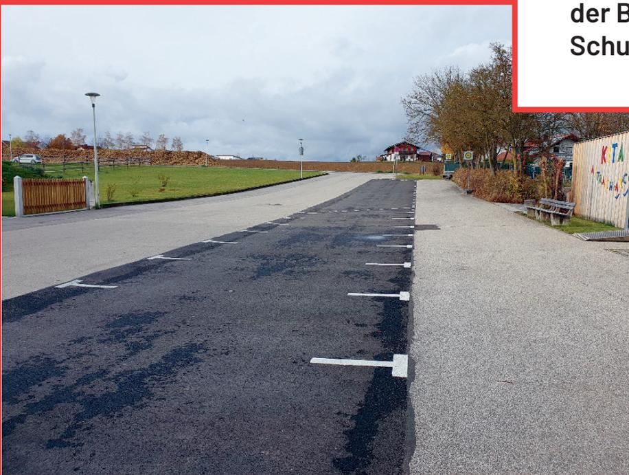
Die Randbefestigung der Sägezahnparkbuchten der Großbusse wurde entfernt und durch Anordnung von Längsparkbuchten ersetzt.
